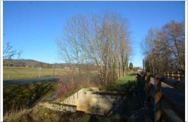
site Pont Lesponne sous l'ancienne voie ferrée
