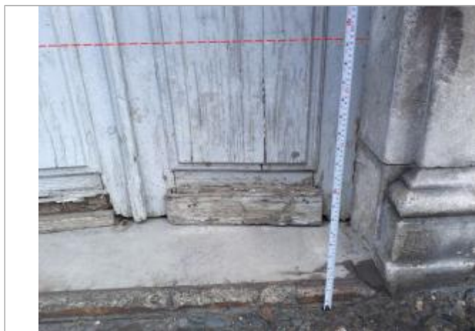
Photo nivellement © Survey
