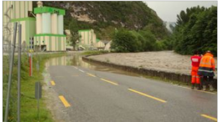
Inondation de la RN 125 au niveau de l'OMG à 12h20
