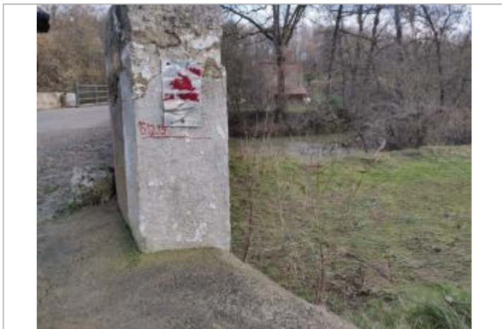
Vue pile amont du pont RG
