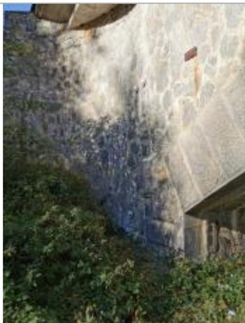
L'ancien repère est sur l'amont. Nous avons placé les trois repères sur la même culée côté amont. Les deux plus haut sont décalés, car leurs proximités en altimétrie ne permettent pas de les mettre l'un au-dessus de l'autre.
