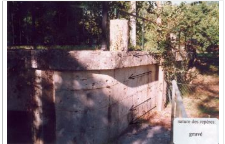
Photo des repères
