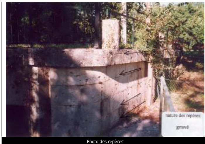
Photo des repères
