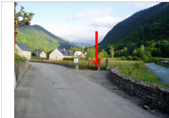
Débris dans le grillage
