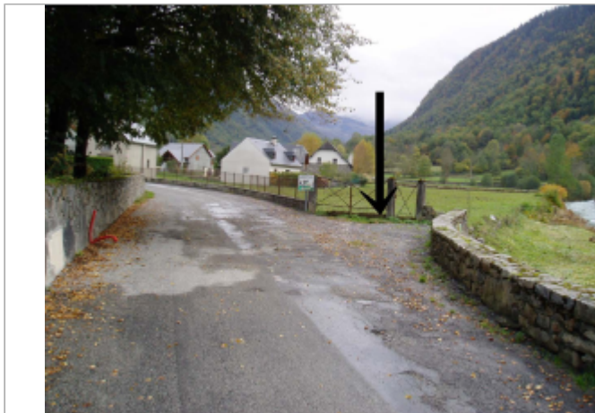
Débris dans le grillage
