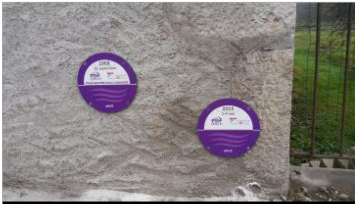
crue du 22 septembre 1968 (en haut)
