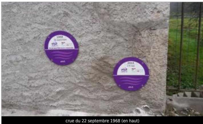
crue du 22 septembre 1968 (en haut)
