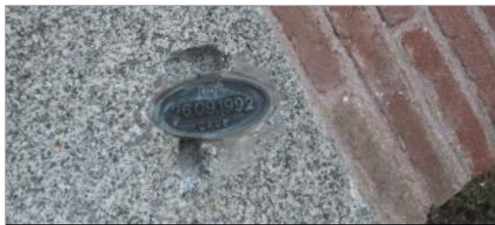
Vue du repère - Auteur : CACG
