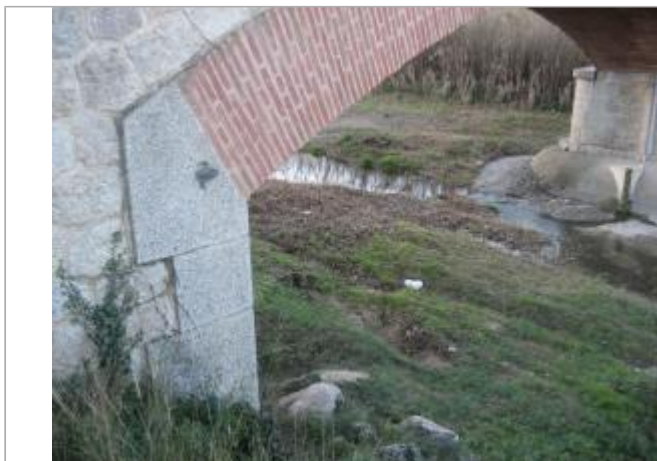
Vue du site - Auteur : CACG
