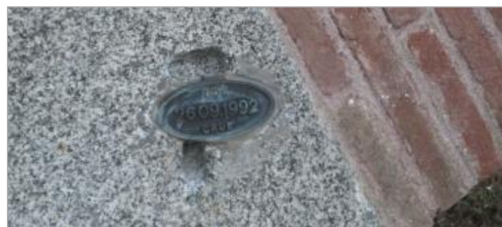
Vue du repère - Auteur : CACG
