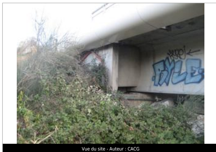
Vue du site - Auteur : CACG
