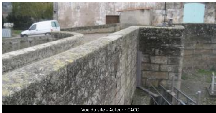
Vue du site - Auteur : CACG
