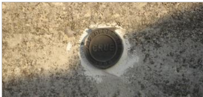
Vue du repère - Auteur : CACG
