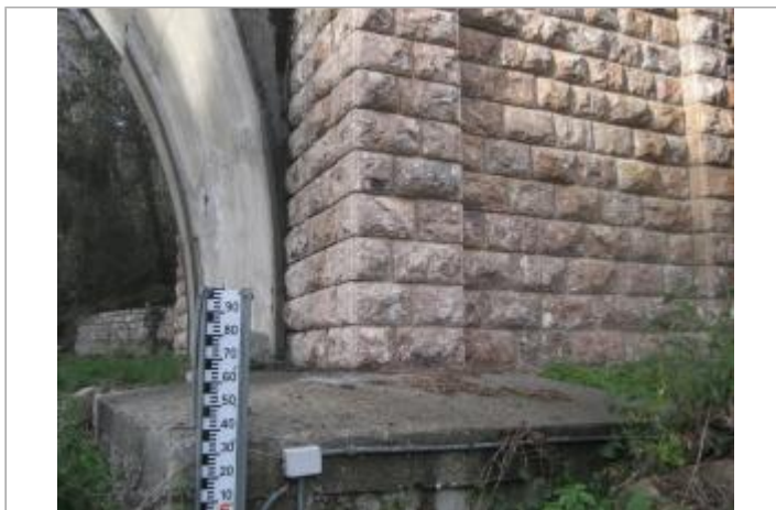
Vue du site - Auteur : CACG
