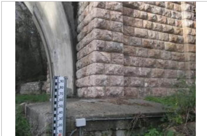
Vue du site - Auteur : CACG
