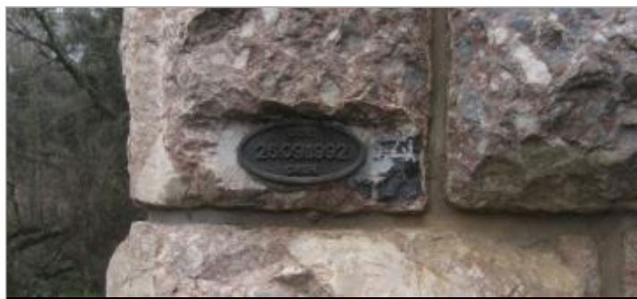
Vue du repère - Auteur : CACG
