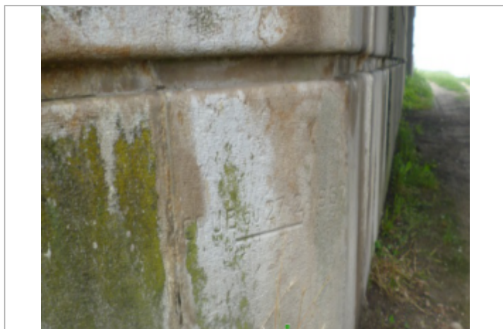
Vue du repère - Auteur : société Grontmij-Parera
