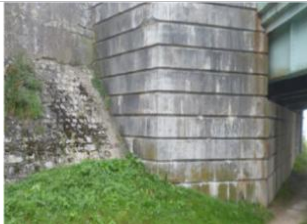
Vue du site - Auteur : société Grontmij-Parera
