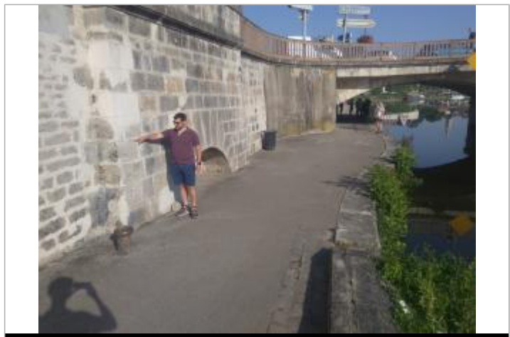
Position du repère en amont rive gauche du pont
