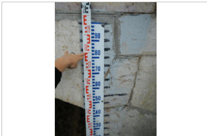
Photo du site - Auteur : Dynamique hydro
