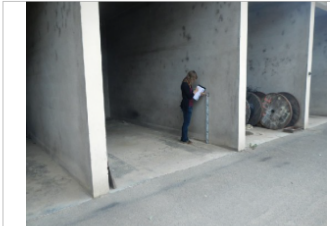
Photo du site - Auteur : Dynamique hydro
