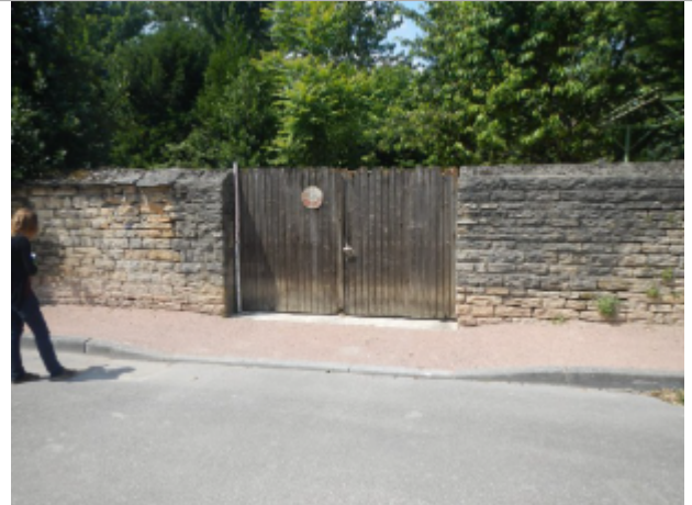
Photo du site - Auteur : Dynamique hydro
