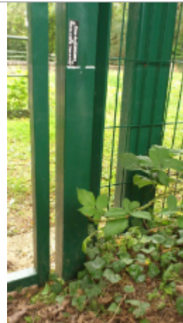
Photo du site - Auteur : Dynamique hydro
