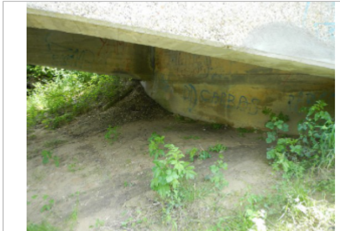
Photo du site - Auteur : Dynamique hydro
