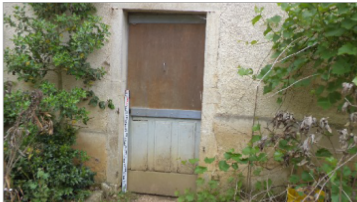
Photo du site - Auteur : Dynamique hydro
