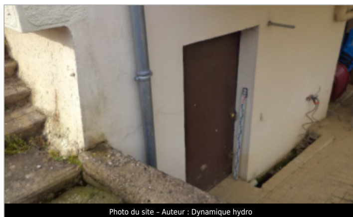
Photo du site - Auteur : Dynamique hydro
