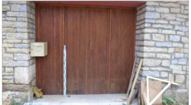
Photo du site - Auteur : Dynamique hydro
