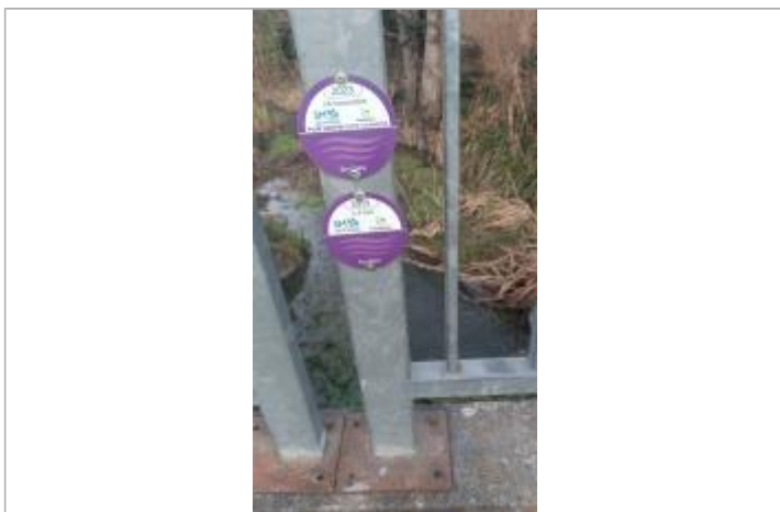
crues des Eaux Belles en 2015 et 2023
