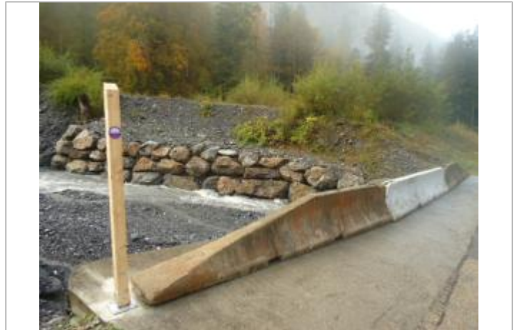
pont de la RD 907
