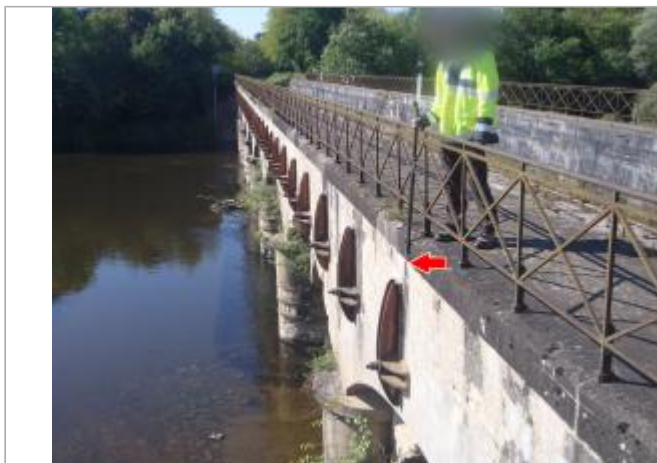
Photo du resencement d'origine (2014), avec le repère de 1940
