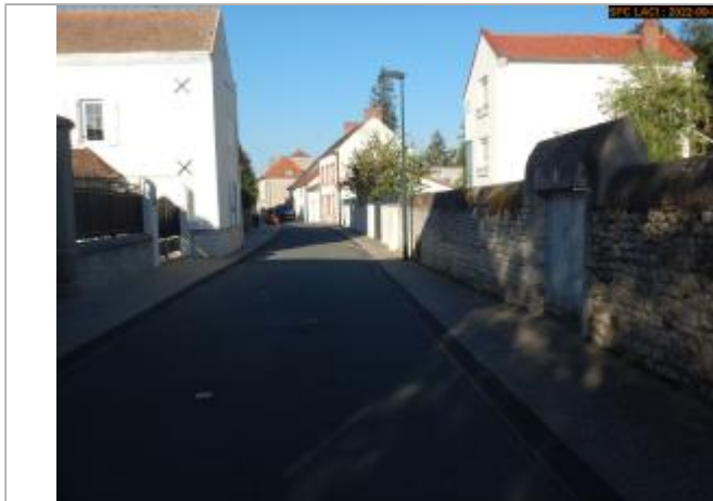
Vue du site éloignée
