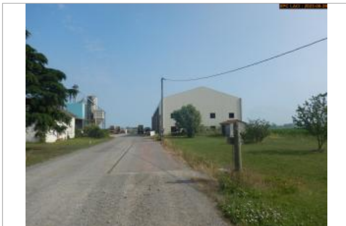
Vue du site en 2023 (avec le nouveau bâtiment)
