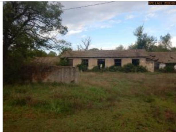
Vue du site éloignée
