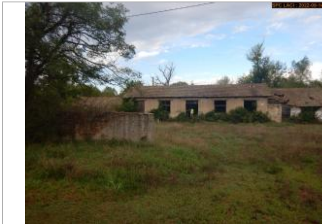
Vue du site éloignée
