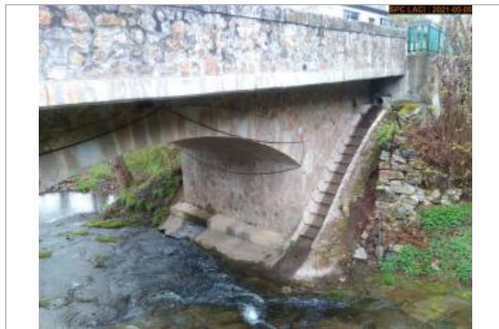
Vue du site en 2021 côté amont
