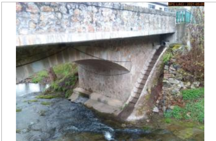
Vue du site en 2021 côté amont
