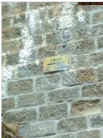
Vue du repère rapprochée en 2021
