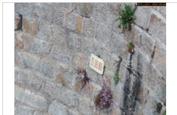
Vue du repère rapprochée en 2021
