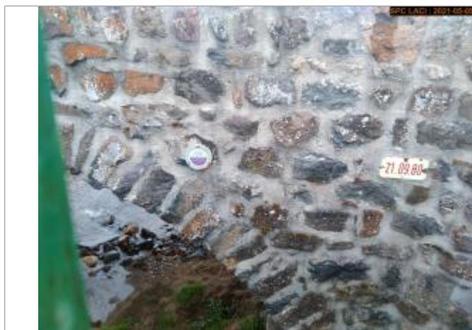
Vue du repère rapprochée en 2021
