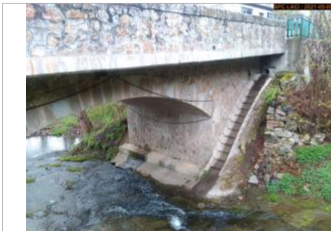
Vue du site en 2021 côté amont
