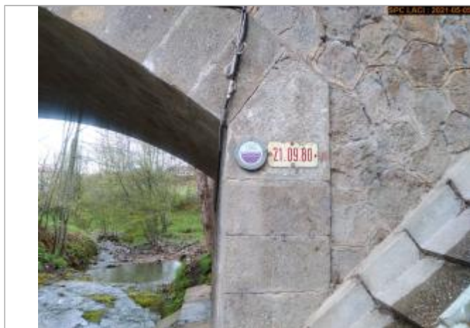
Vue des repères en 2021 côté amont
