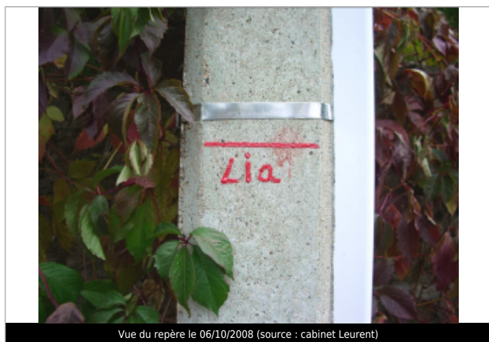
Vue du repère le 06/10/2008 (source : cabinet Leurent)
