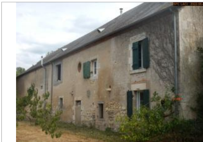
Vue du site éloignée
