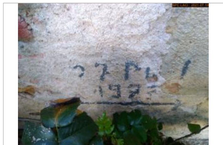
Vue du repère rapprochée en 2021
