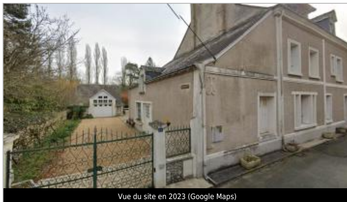
Vue du site en 2023 (Google Maps)
