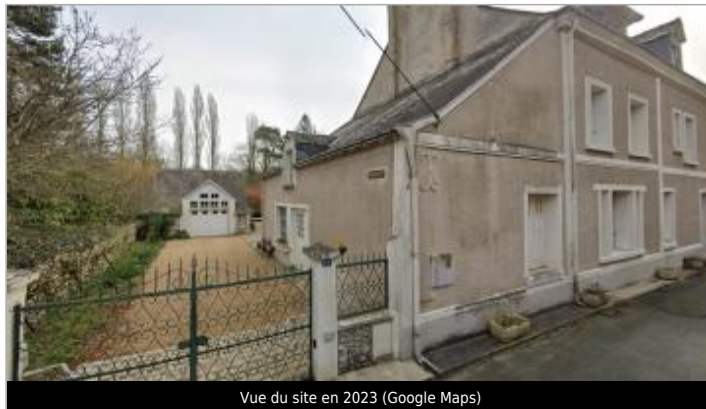
Vue du site en 2023 (Google Maps)
