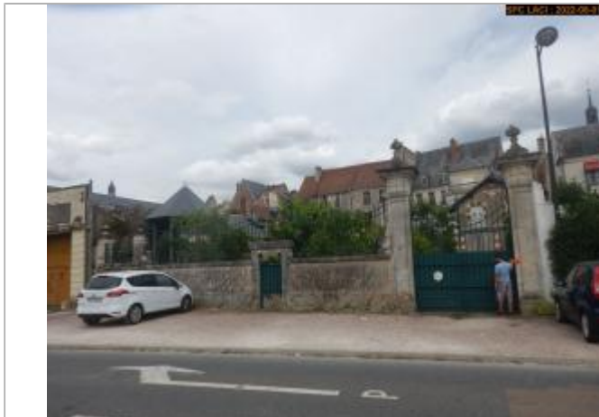
Vue du site éloignée
