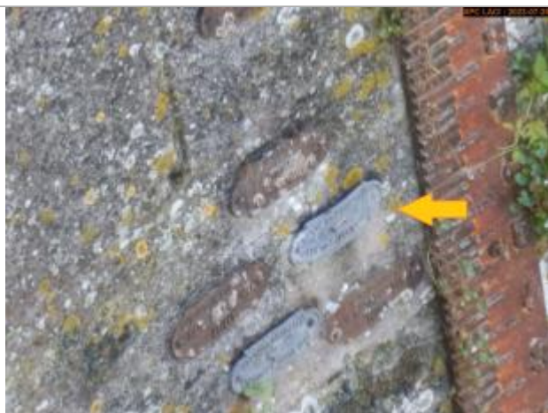
Vue du repère en 2023
