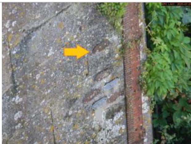
Vue du repère en 2023
