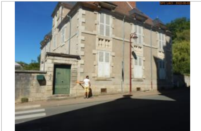
Vue du site éloignée
