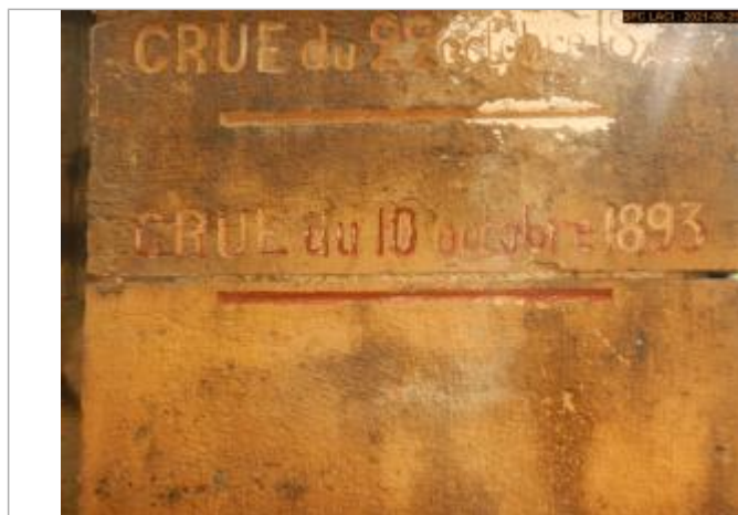
Vue du repère rapprochée
