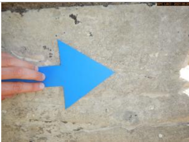
Vue du repère rapprochée
