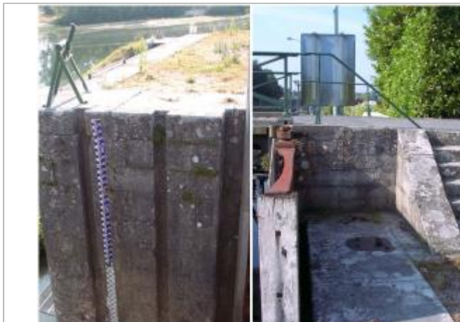
Vue sur site : l'échelle et le musoir de l'écluse
