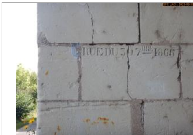
Vue du repère rapprochée en 2021
