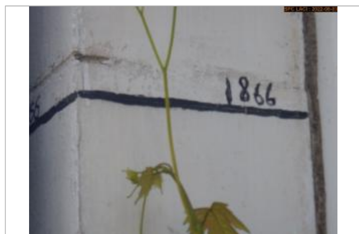
Vue du repère (montant intérieur)
