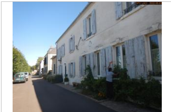
Vue du site éloignée
